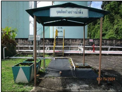
ภาพถ่ายที่ 2.2-7 บ่อดักไขมันและบ่อกักน้ำทิ้งภายในพื้นที่คลังฯ
