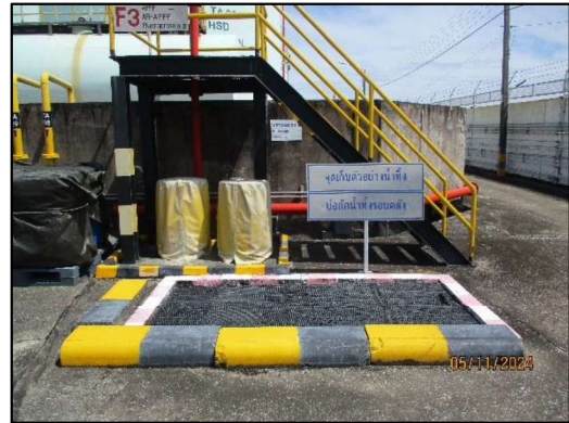
ภาพถ่ายที่ 2.2-7 บ่อดักไขมันและบ่อกักน้ำทิ้งภายในพื้นที่คลังฯ
